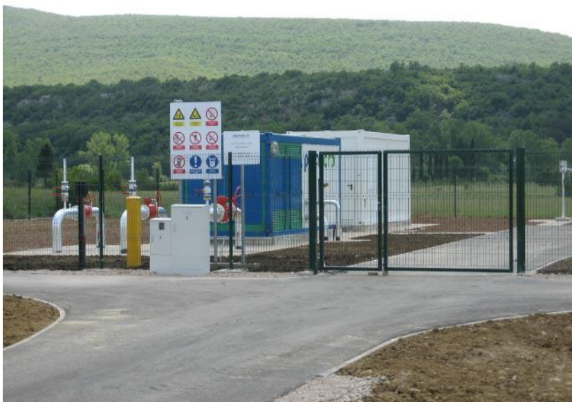
Slika 15. Tipska kontejnerska mjerno-redukcijska stanica
